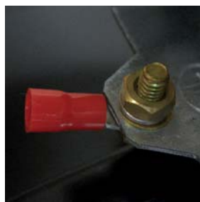
Клемма заземления корпуса
