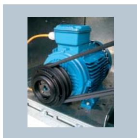
Система натяжения ременной передачи
